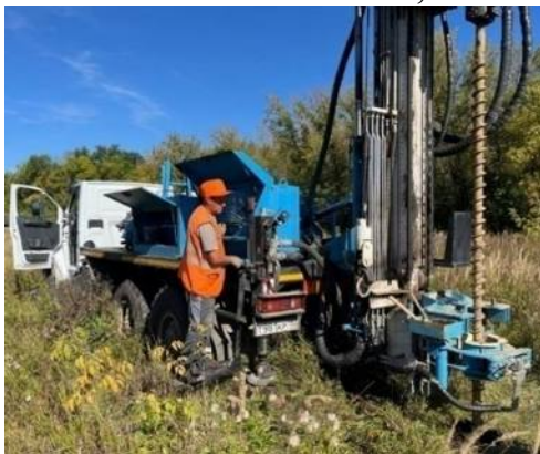
Рисунок 1 – Инженерно-геологические работы с применением буровой установки УРБ-51 на базе автомобиля Урал
